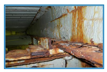
HEAVY RUST AND STEEL DELAMINATION
